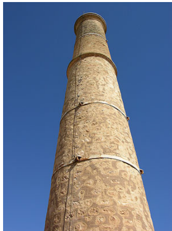
Chimney (note lightning rod), 2005
